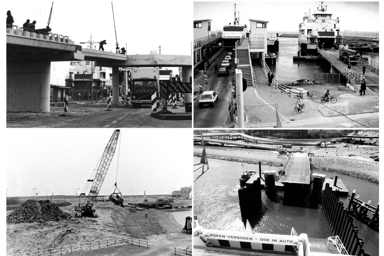
Werkzaamheden veerhavens in de jaren '80. De schepen meerden toen af aan een tijdelijke brug.
